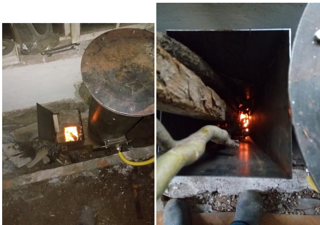
Figura 41. Vedere frontală a CT cu gazeificare
